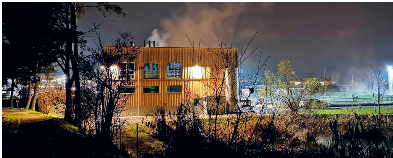
In der Heizzentrale der Wärme Bischofszell-Sittertal AG wird dem Abwasser der ARA Wärmeenergie entzogen.
