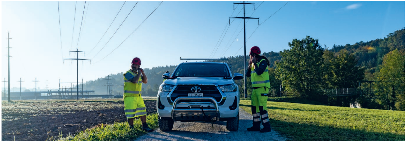
Die sichere Versorgung des Kantons Thurgau mit Strom: Kernauftrag der EKT AG seit 1912 und täglicher Antrieb der Mitarbeitenden des Geschäftsfelds «Netz».
