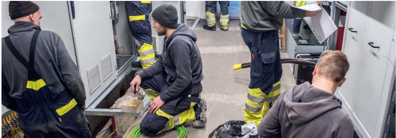
Umfassende Trafostation-Umbauten sind eine der Dienstleistungen, die bei der EKT im Geschäftsfeld «Netzdienstleistungen» zusammengefasst sind.
