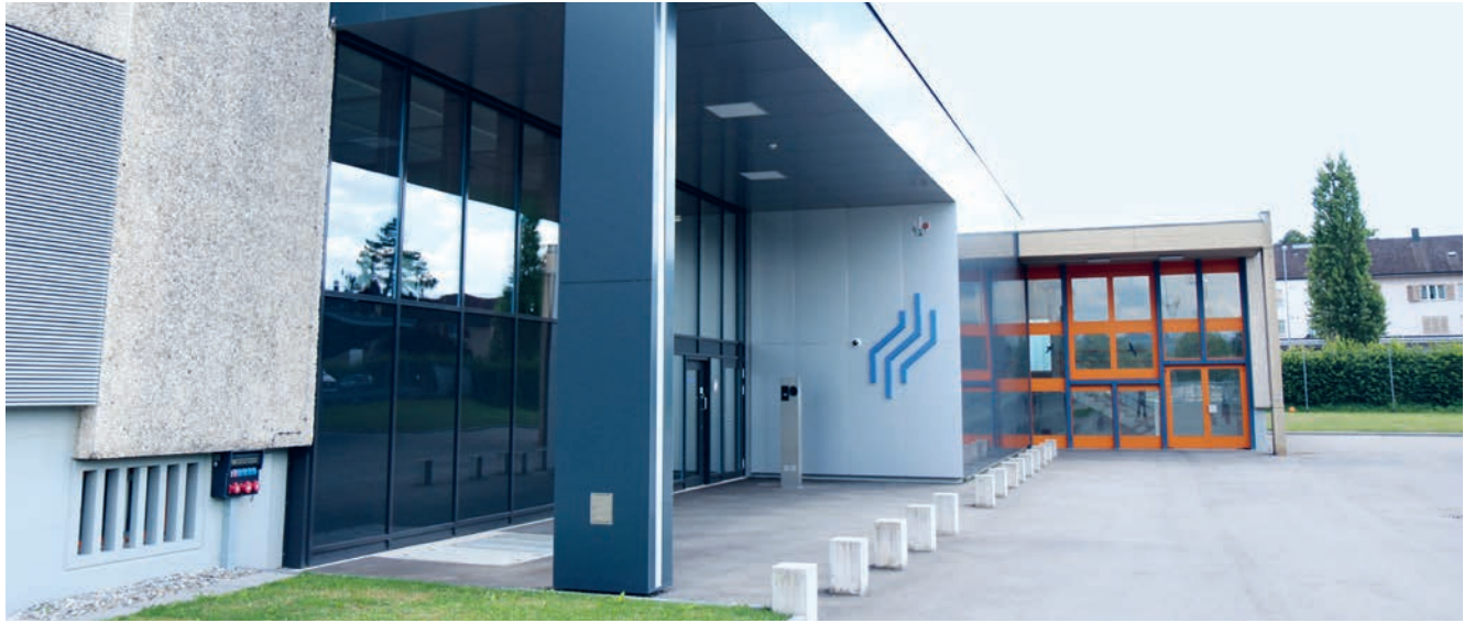
Das Datacenter Thurgau in Frauenfeld wurde im Berichtsjahr voll ausgebaut.
