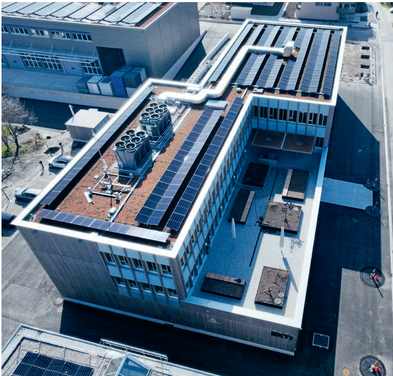
Das neue Betriebsgebäude der EKT wurde Ende 2025 fertiggestellt. Mitte Januar 2026 zogen rund 70 Mitarbeitende von Arbon hierher.
